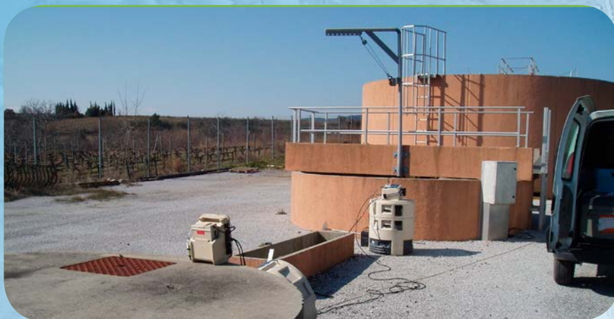
Bilan 24h station d'épuration de Babeau Bouldoux bourg
