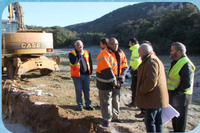
Murles : visite d'un chantier de pose de canalisation
