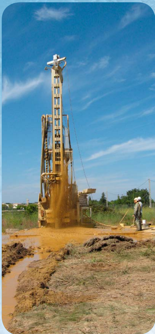
Lunel-Viel "les Horts" : chantier de recherche d'eau par forage
