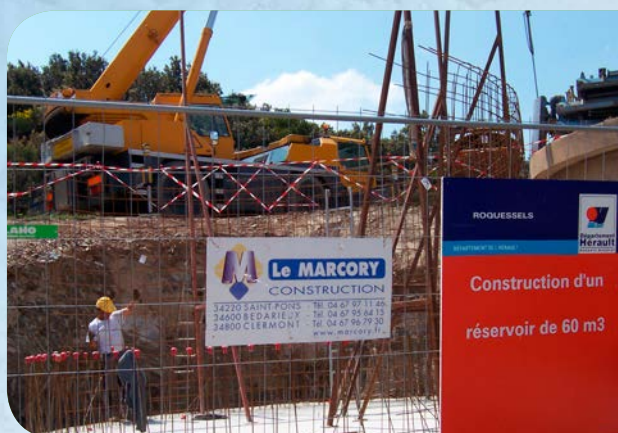
Roquessels : construction d'un réservoir d'eau potable
