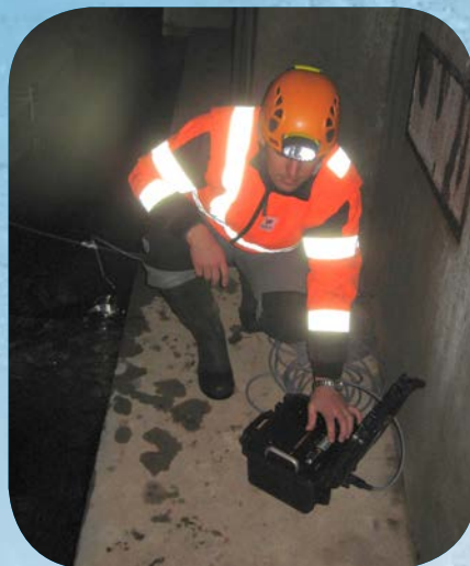
Laurox : source Payrols nord, pose de matériels de mesure
