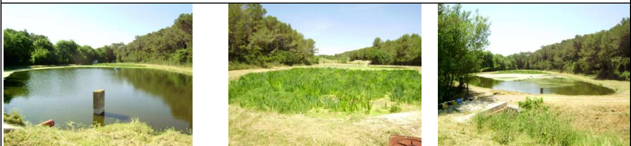
Digue filtrante de VERARGUES
