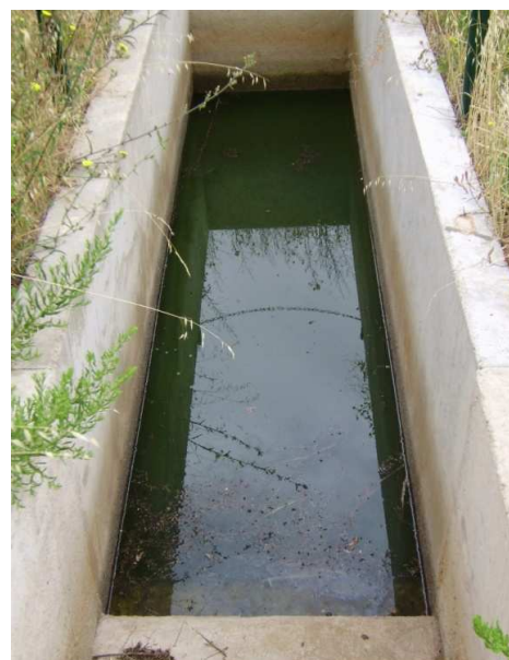
Figure 1 Canal de comptage en charge
