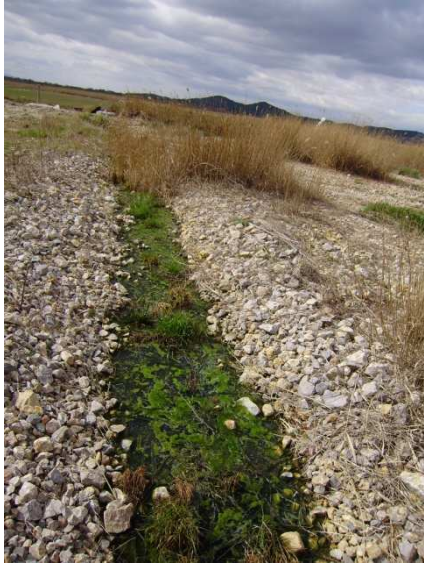
Figure 5 : reprise hydraulique de sortie avec écoulement très faible
