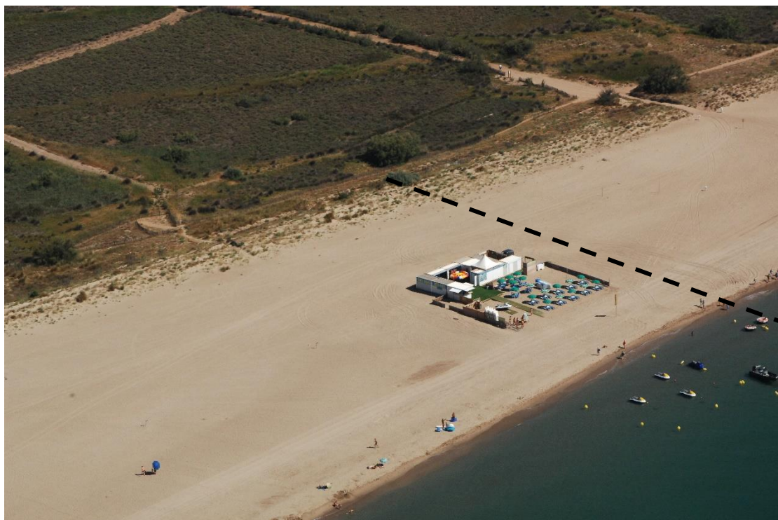
Figure 3 : Vue aérienne de l'emplacement du profil Ve01 (EID Méditerranée 2018)
