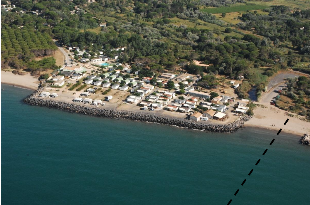
Figure 20 : Vue aérienne de l'emplacement du profil P15 (EID Méditerranée 2018)
