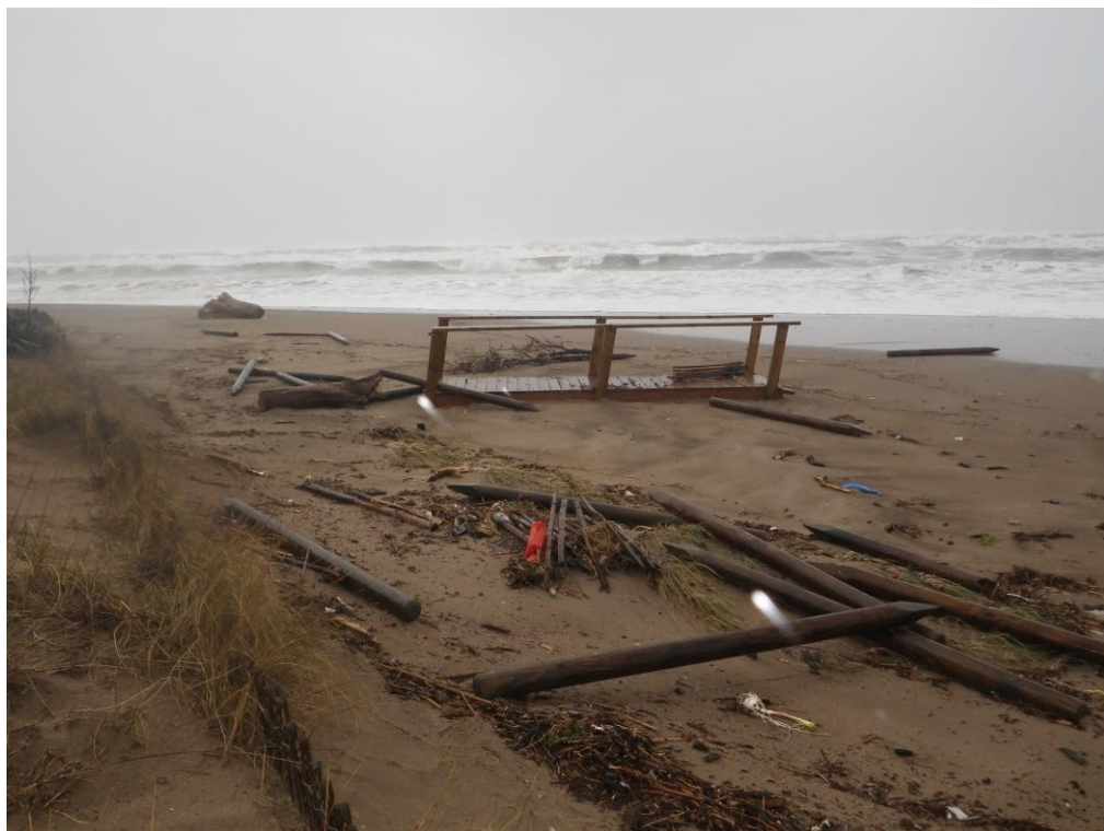
Rivierette : érosion et submersion. Une passerelle handicapée s'est déchaussée et a été emportée sur cette plage.
