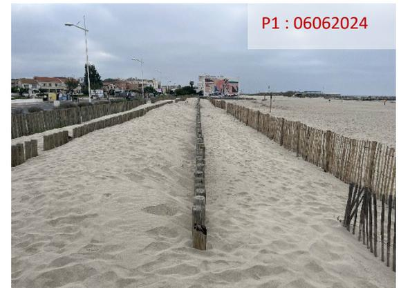
À l'ouest du port de Carnon, en rive droite, l'ouvrage de piégeage sableux en pieux témoigne de l'évolution des phases d'ensablement de la plage. Le sable piégé par l'ouvrage est régulièrement retiré par les services techniques de la commune et redéposé sur la plage. Début 2024, une ligne de ganivelle a été ajoutée devant l'ouvrage.
