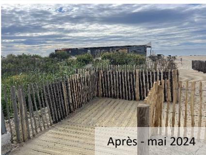
Accès 24 : enlèvement et évacuation du platelage et des ganivelles dégradés, mise en place d'un platelage et de ganivelles d'encadrement neufs.
