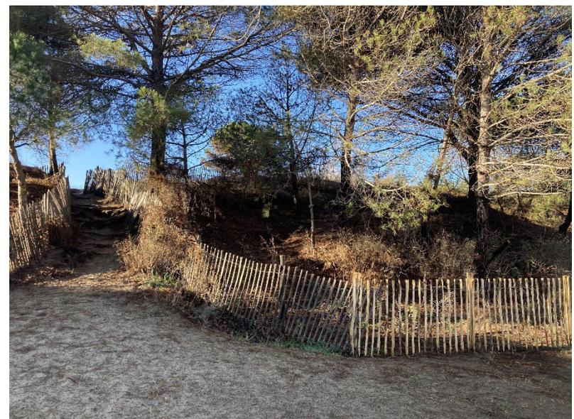
Sur la plage de la Tamarissière (au niveau de la digue de l'Hérault), les casiers de ganivelles installés en haut de plage en 2022 remplissent leur rôle de piège à sable pour limiter l'ensablement du parking voisin.
