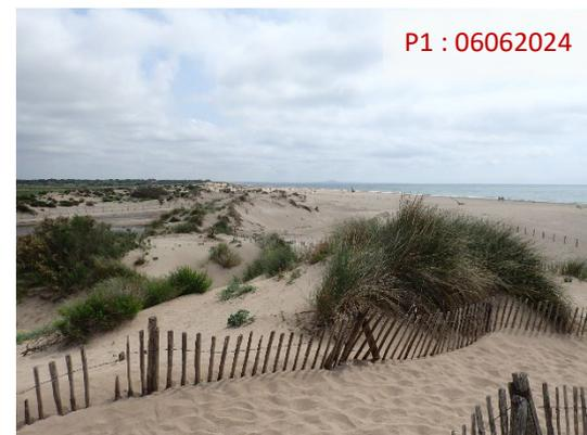
Sur ce secteur, observé depuis la limite communale ouest, des aménagements récents sont visibles (ganivelles). À titre expérimental un cordon sableux recouvert de copeaux de bois flotté broyé a été édifié en 2019 pour combler une faiblesse dunaire. Depuis, un creusement s'est formé en 2021 et s'est accentué (cf. partie aménagements et observations récentes). En 2023, les coups de mer successifs du 19 au 24 octobre ont entraîné une submersion de la plage des Orpellières visible sur la photo.
