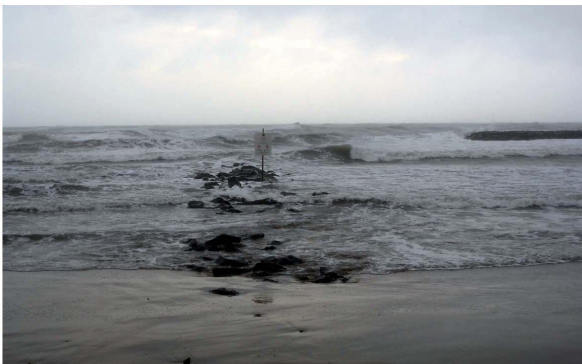
Mêmes lieu et date que la photo précédente ; les rochers visibles ici constituent le reliquat d'une ancienne piste de construction de brise-lames, qui joue le rôle d'un épi imparfait, étant largement franchi par la mer ; il est sans doute inutile de le conserver.
