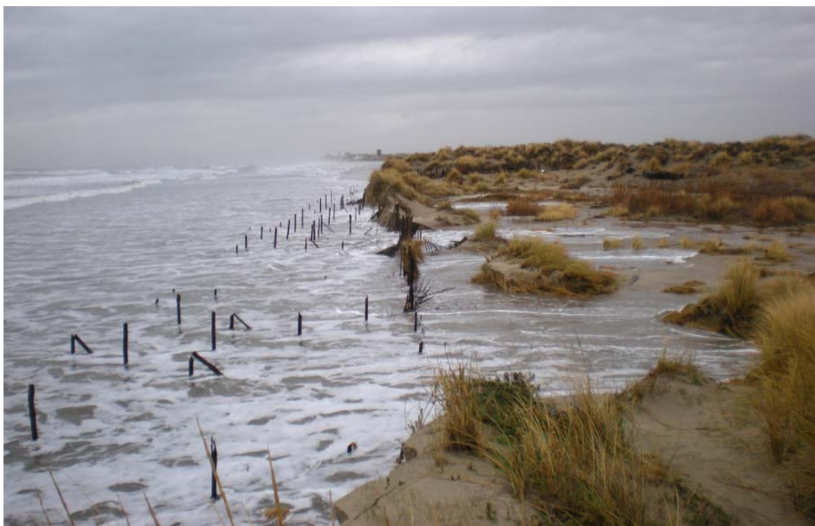
Même date que la photo précédente, à proximité (PK 1,6) ; le cordon dunaire est franchi et arasé ; il a été reconstitué depuis le printemps, lors des opérations de rechargement de la plage.
