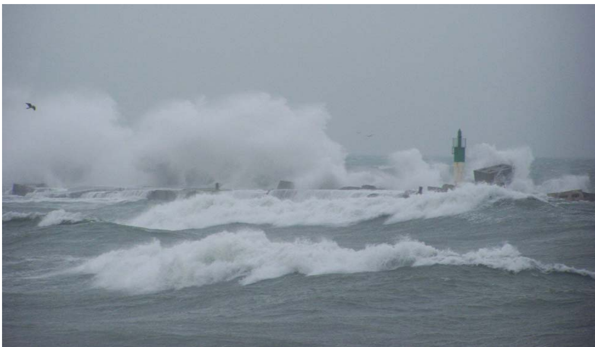
14 janvier 2008 ; vue du coup de mer dans le secteur de la corniche, submergeant la digue.
