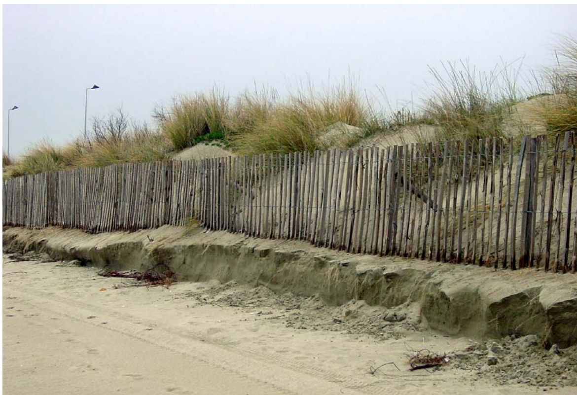
10 janvier 2008, secteur du Grand Travers ; le coup de mer précédent a érodé le haut de plage ; une micro-falaise déchausse le pied de dune et les ouvrages en ganivelles.
