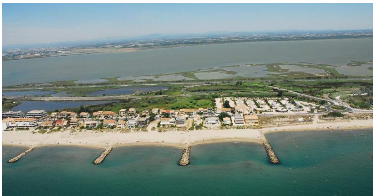
Figure 31 : vue aérienne des épis visible à la limite de la zone urbanisée du secteur est de Carnon. Le dernier épi montre un écart bien visible de la position du trait de côte, délimitant le début de l’encoche d’érosion de la plage du Petit Travers (image aérienne EID/CD34 2018)
