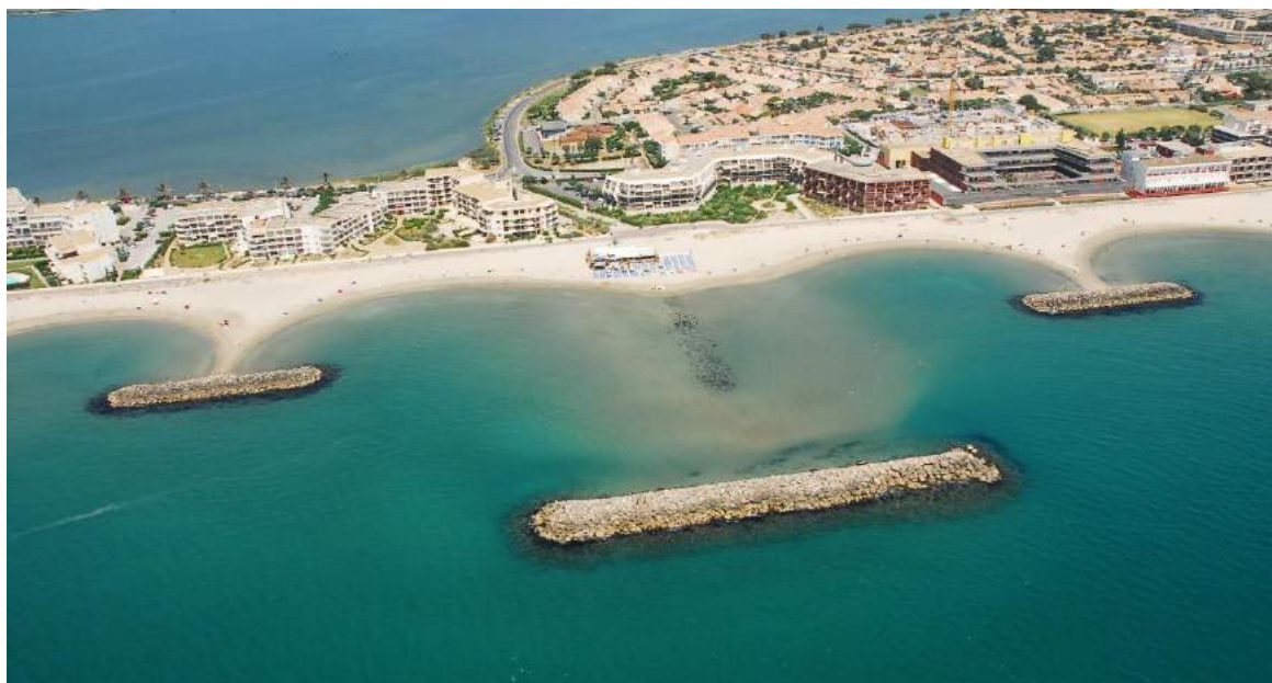
Figure 30 : vue aérienne des brise-lames situé sur la rive droite du littoral de Palavas les Flots (image aérienne EID/CD34 2018)
