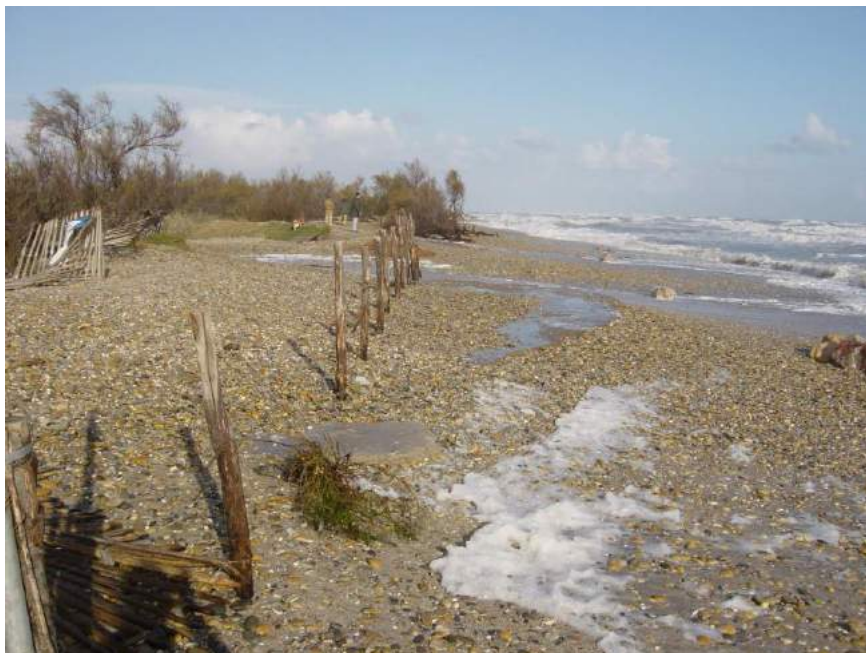
Figure 12 : Dégâts visibles sur la plage des Aresquiers suite à la tempête de février 2004
