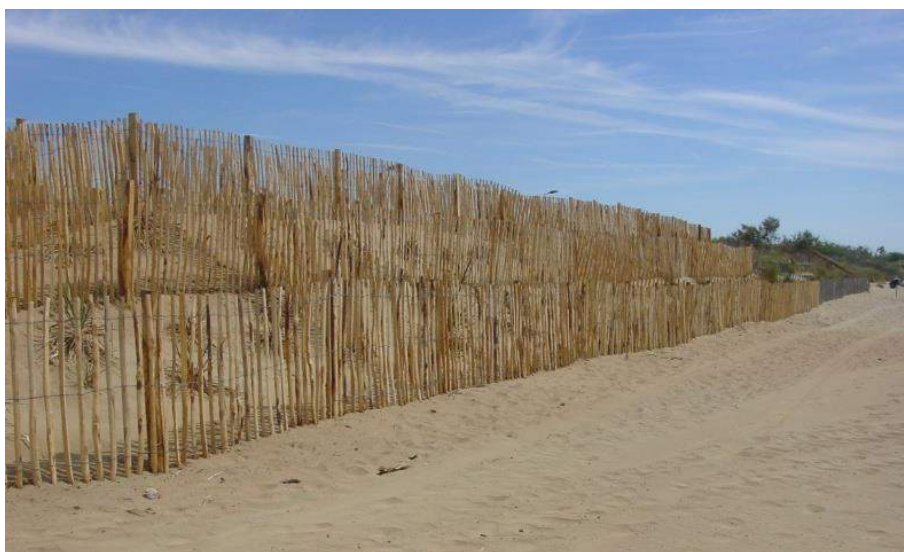
figure 51 : cordon dunaire reconstitué et protégé par maillage de ganivelles, Vias, Farinette, mai 2017 (photo EID)
