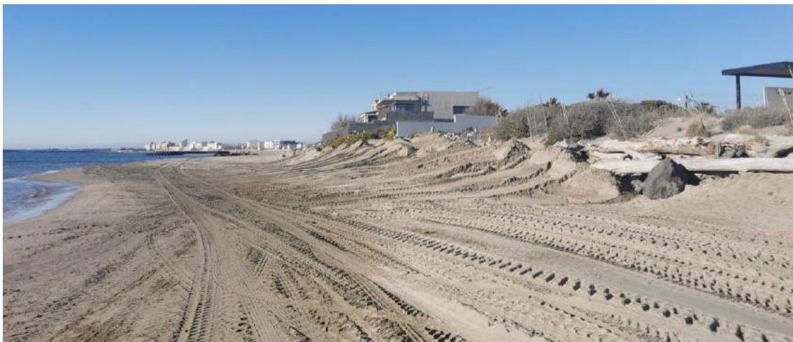
figure 60 : rechargement de la plage de Rochelongue en 2022 (photo EID)
