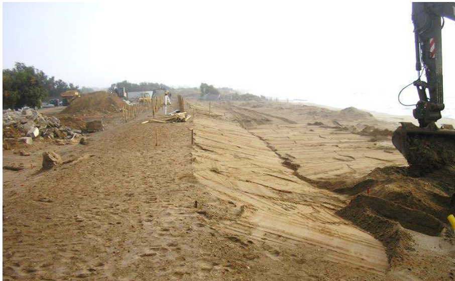
figure 48 : façonnage du nouveau cordon dunaire à Portiragnes, la Redoute, octobre 2010 (photo EID)
