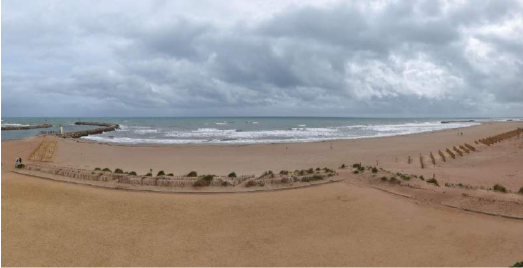
figure 44 : ouvrages de rétention du sable en haut de plage urbaine de Valras (source : webcam de beziers-mediterranee.com)
