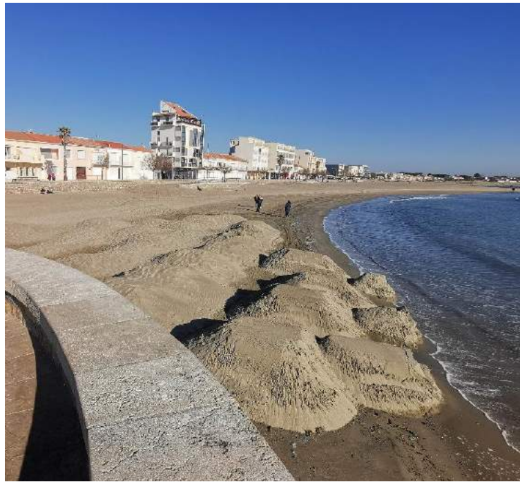
figure 59 : rechargement de la plage du grau d'Agde en 2022 (photo EID)
