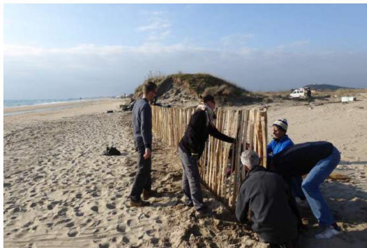
figure 65 : travaux de protection dunaire au Bagnas (photo ADENA)
