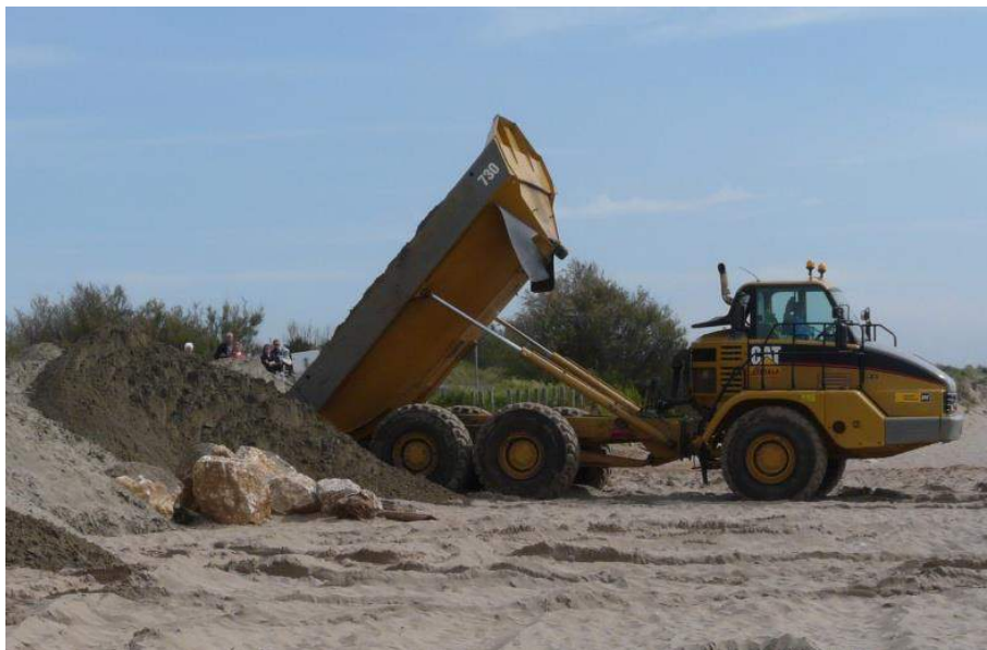
figure 49 : apport sableux mis en forme sur la plage de Portiragnes, avril 2015 (photo EID)
