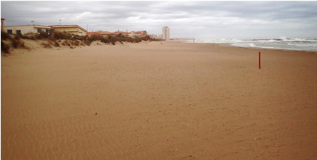
Figure 18 : photographie du 20 octobre 2020 lors d'un petit coup de mer du début de la plage de Valras face au brise-lames et au cordon refait en 2007 (© photo EID-Med ; N.B. : le profil Va3 se situe dans le fond de la photo, après le second piquet en bois sur la plage).
