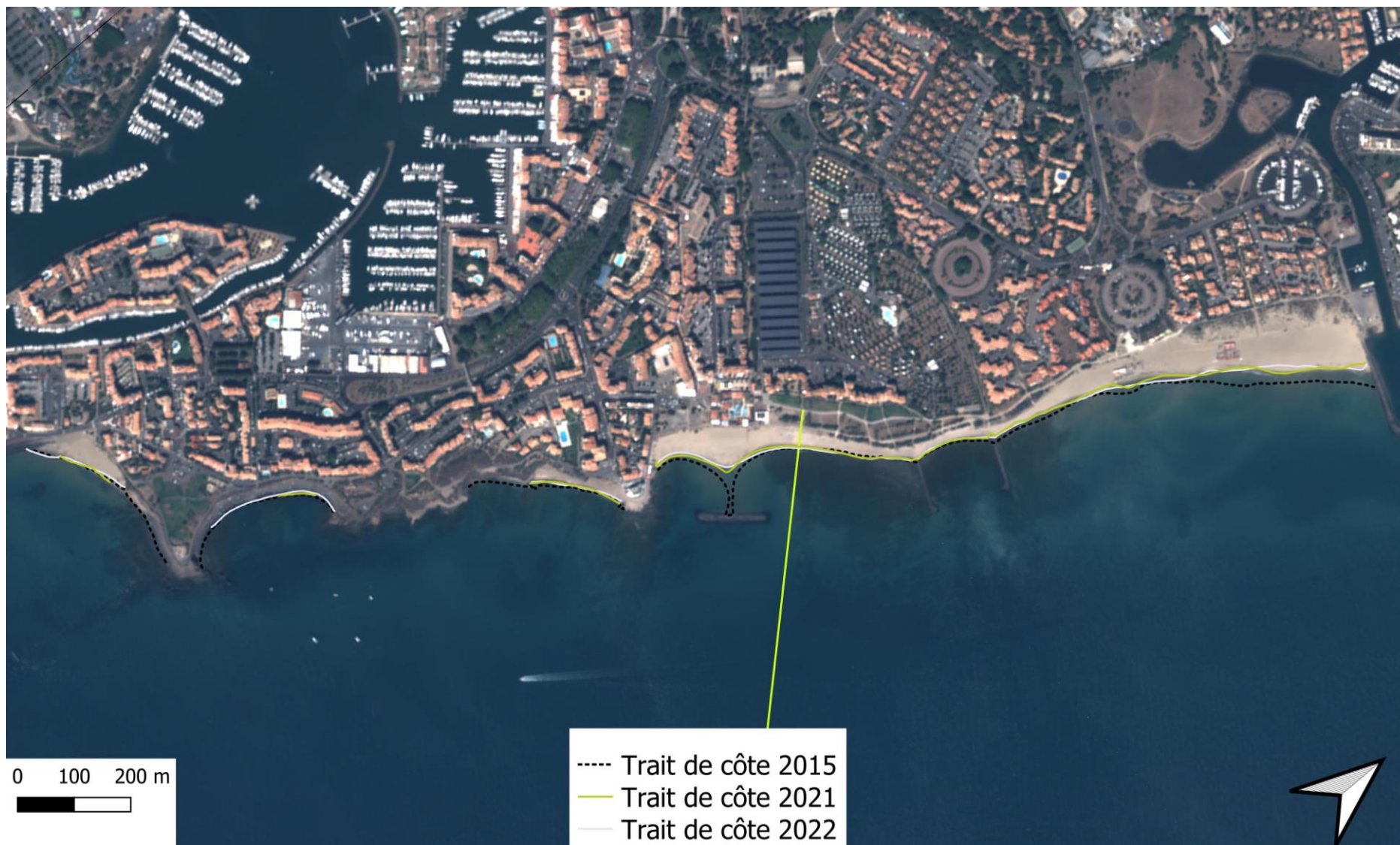
Figure 74 : variations du trait de côte entre 2015 (pointillé), 2020 (position du trait de côte visible sur l'image), 2021 (jaune) et 2022 (bleu) sur la partie ouest du secteur 9 (orthophotographie Pléiades 2020)
