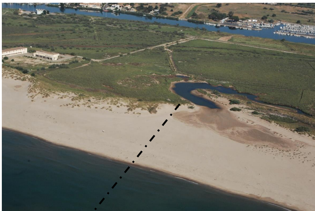
Figure 26 : photographie aérienne du secteur de plage du profil P44 à la limite du grau des Orpellières (en trait pointillé) pris en vue aérienne le 27 juin 2018 (photo © EID-Med, CD 34)
