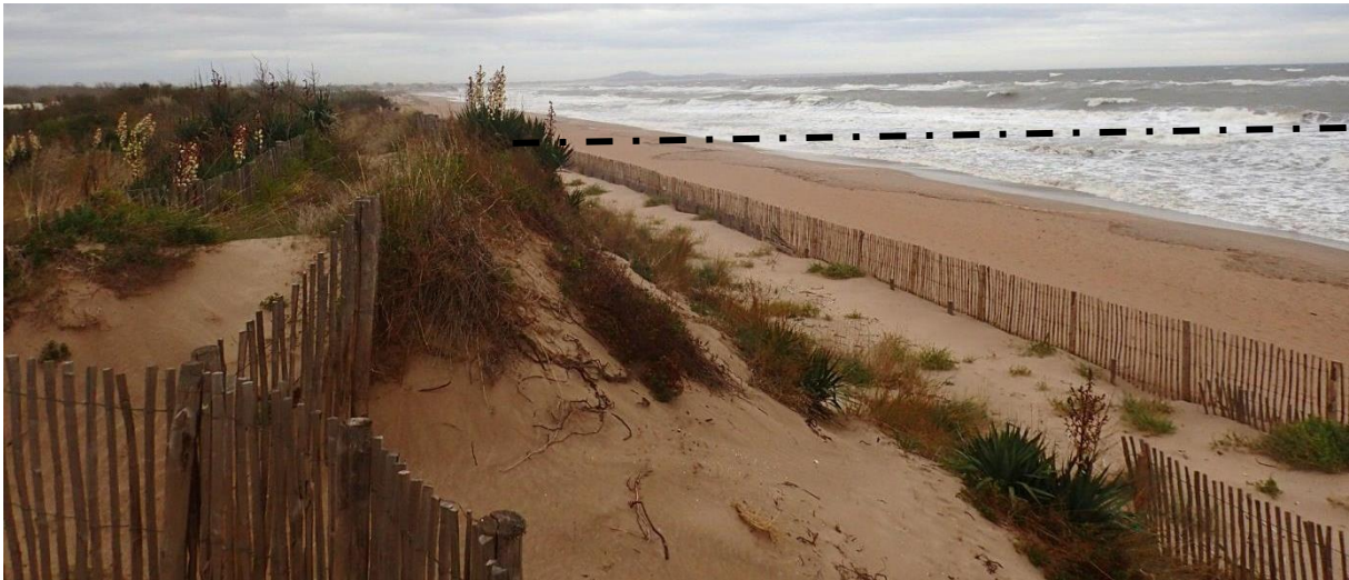
Figure 48 : photographie du 20 octobre 2020 montrant la zone du grand cordon dunaire à l'est de Portiragnes où passe le profil P25 (© photo EID-Med, 2020).
