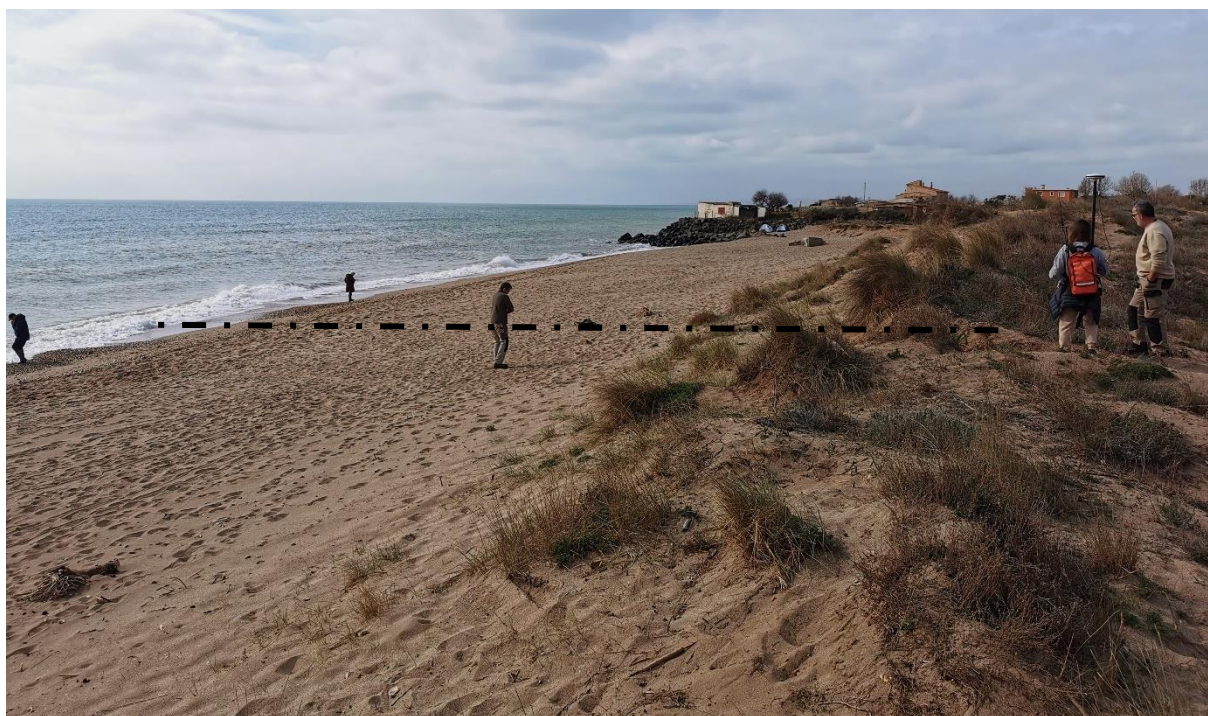
Figure 55 : photo prise de la partie centrale-Est du cordon de Vias le 24 février 2022, juste après les enrochements du camping « Le Petit Mousse », à proximité du profil P21 (pointillés sur la photographie)
