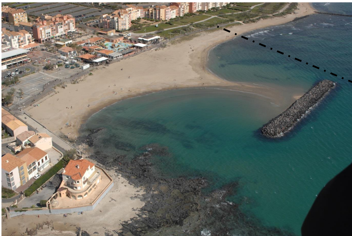
Figure 84 : vue aérienne de la plage du Môle le 15 avril 2016 (© photo EID & CD-34, 2016).
