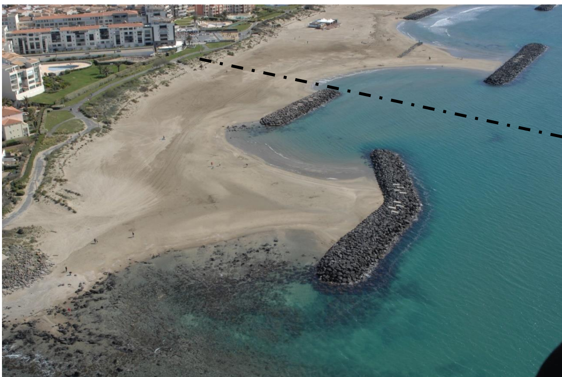
Figure 75 : photographie aérienne du secteur du profil P13-Rochelongue (position approximative en pointillés). Cliché pris le 15 avril 2016 (© photo EID-Méd., CD-34)
