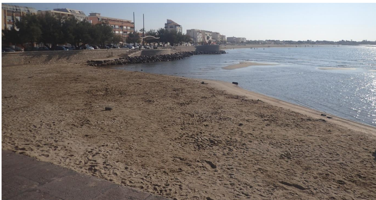
Figure 131 : photographie du 14 septembre 2020 montrant le principal problème lié à l'aménagement du front de mer (point de vue depuis la digue de l'Hérault ; © photo EID-Méd, 2020)
