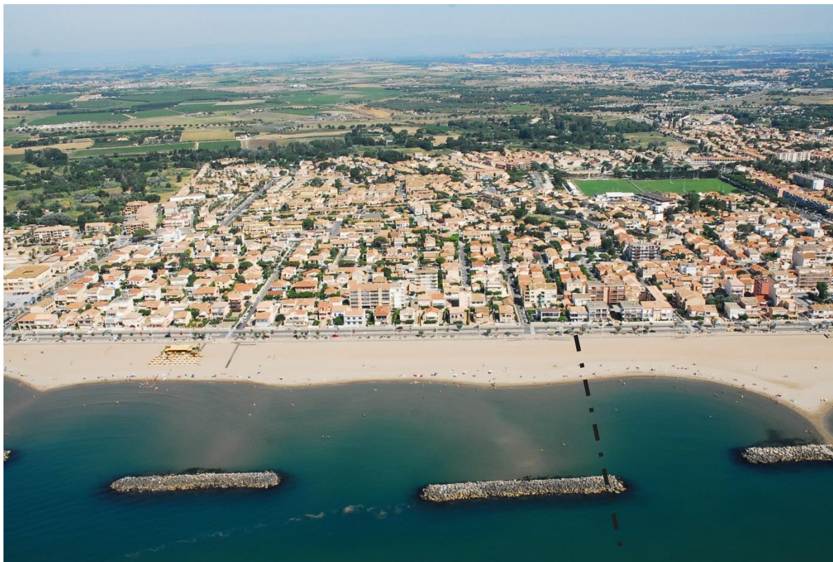
Figure 59 : photographie aérienne du secteur de plage du profil Bt129740 (en trait pointillé) pris en vue aérienne le 27 juin 2018 (photo © EID-Méditerranée, CD-34)
