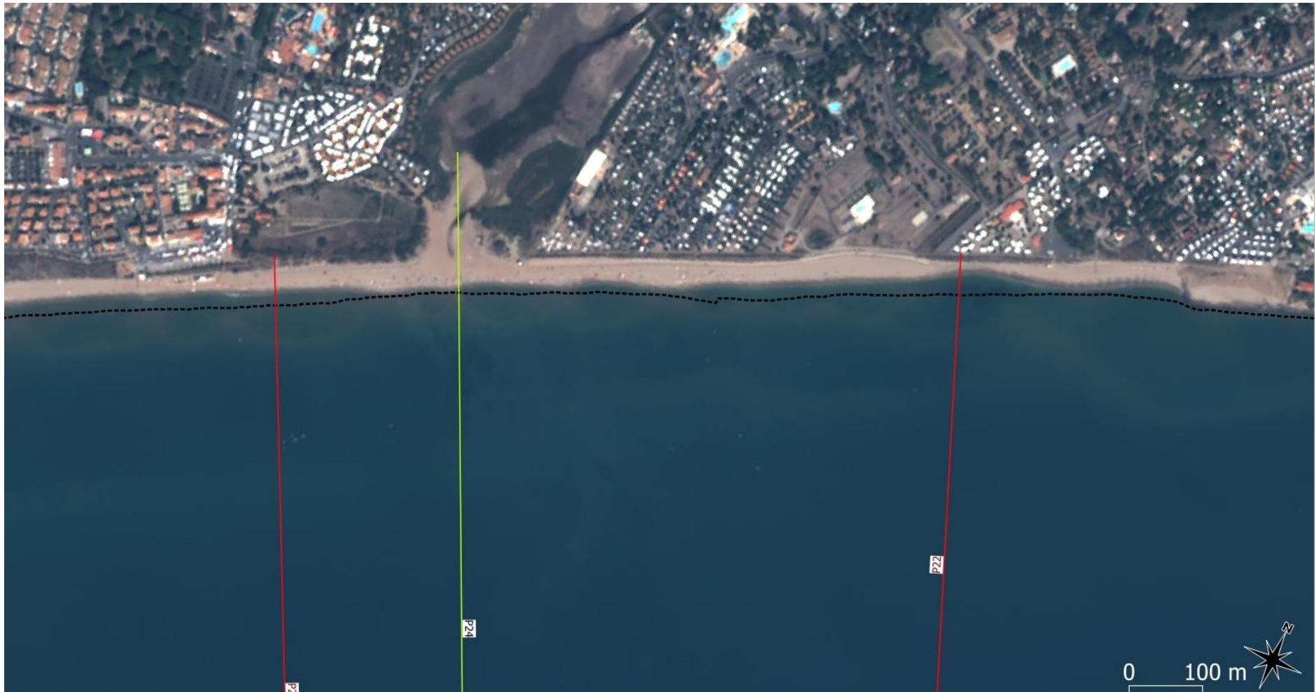
Figure 89 : ortho-photographie 2020 (Pléiades) du secteur 5 (Vias côte ouest) montrant la morphologie de la plage et des barres d'avant-côte (visibles par transparence de l'eau). La position du trait de côte en 2015 est rappelée par un trait pointillé noir.
