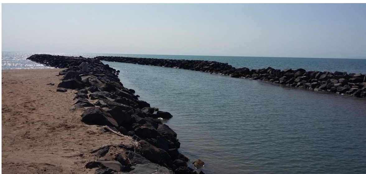
Figure 111 : photos montrant la partie de l'exutoire en mer du libron avec la présence de bancs de sable accrochés le long des digues, en particulier le long de la digue ouest (© photo EID-Méd., 30.09.2020)
