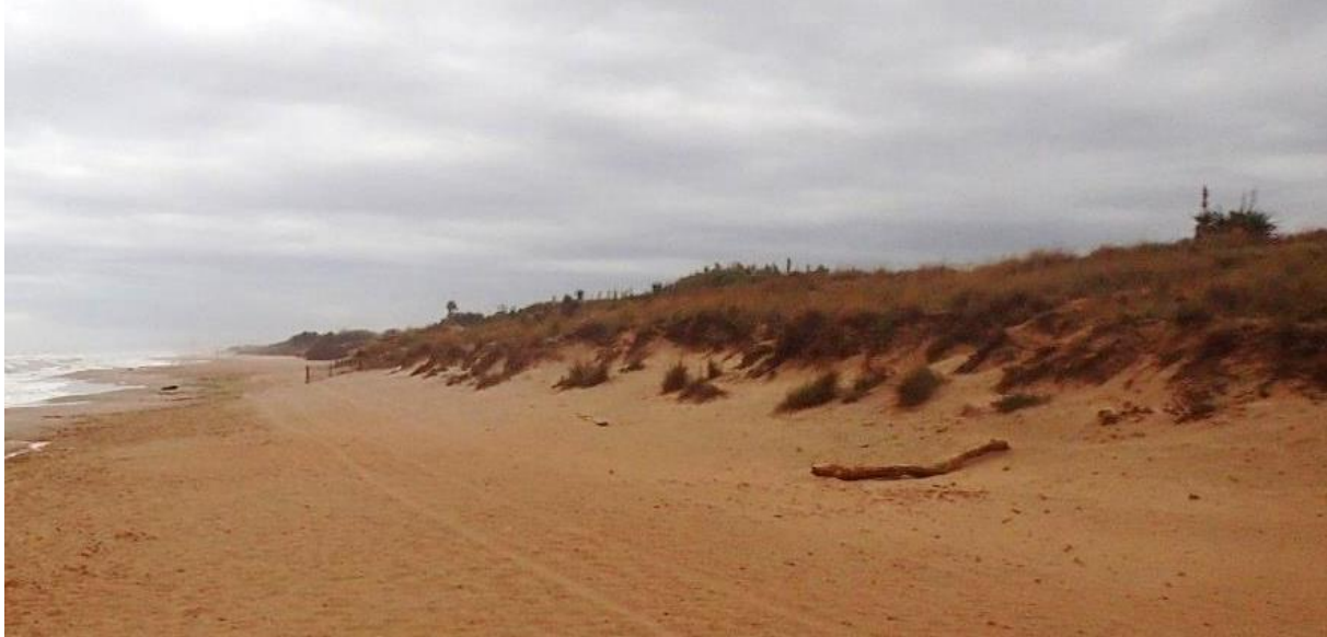
Figure 78 : photographie de la plage du secteur du profil P32 (secteur en érosion de Sérignan où la ganivelle de 2017 avait été arrachée par la mer) pris en vue oblique depuis l'accès à la plage du grand parking lors d'un petit coup de mer le 20 octobre 2020 (photo © EID-Méditerranée, 2020)
