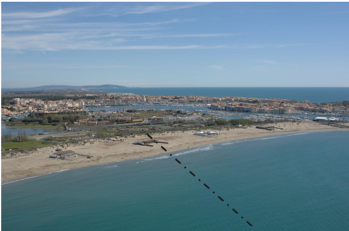
Figure 144 : photographie aérienne du secteur du profil P17-Richelieu (position approximative en pointillés). Cliché pris le 15 avril 2016 (© photo EID-Méd., CD-34)
