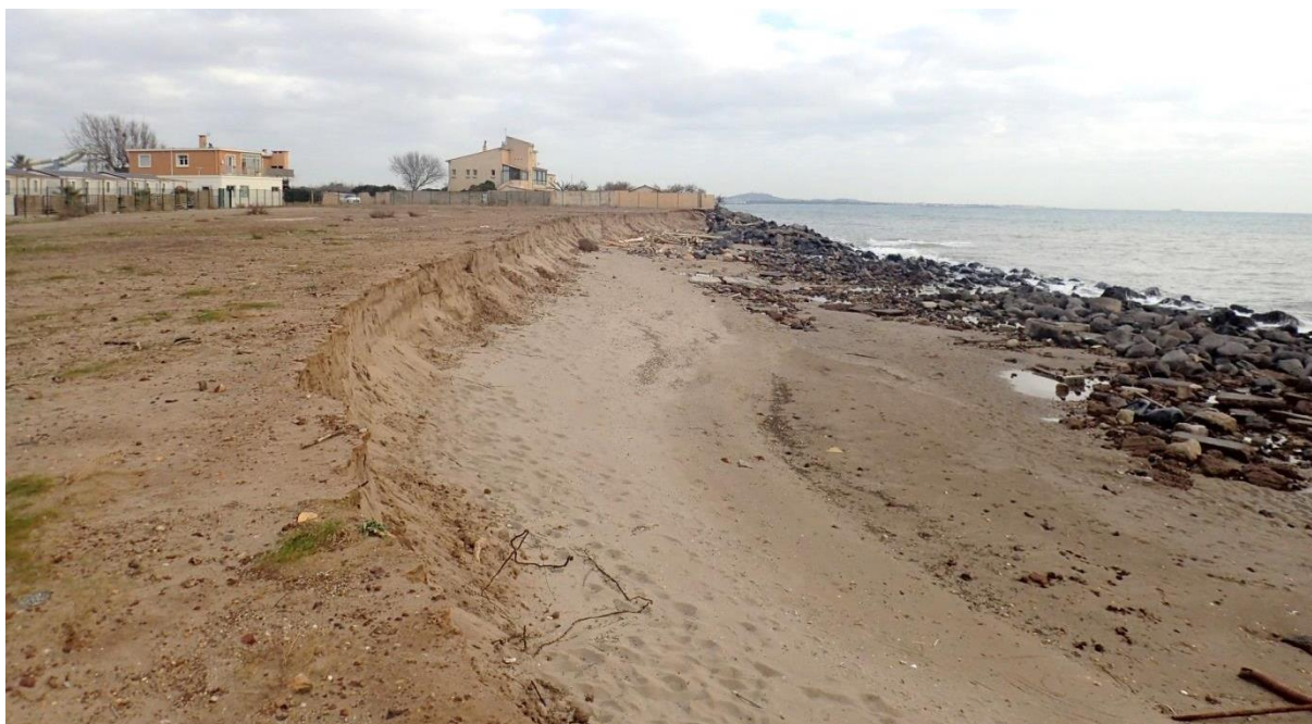
Figure 103 : photo prise de la zone terrassée à l'extrémité de la plage, en forte érosion également malgré son cerclage de rochers (© photo EID-Méditerranée, 2020)
