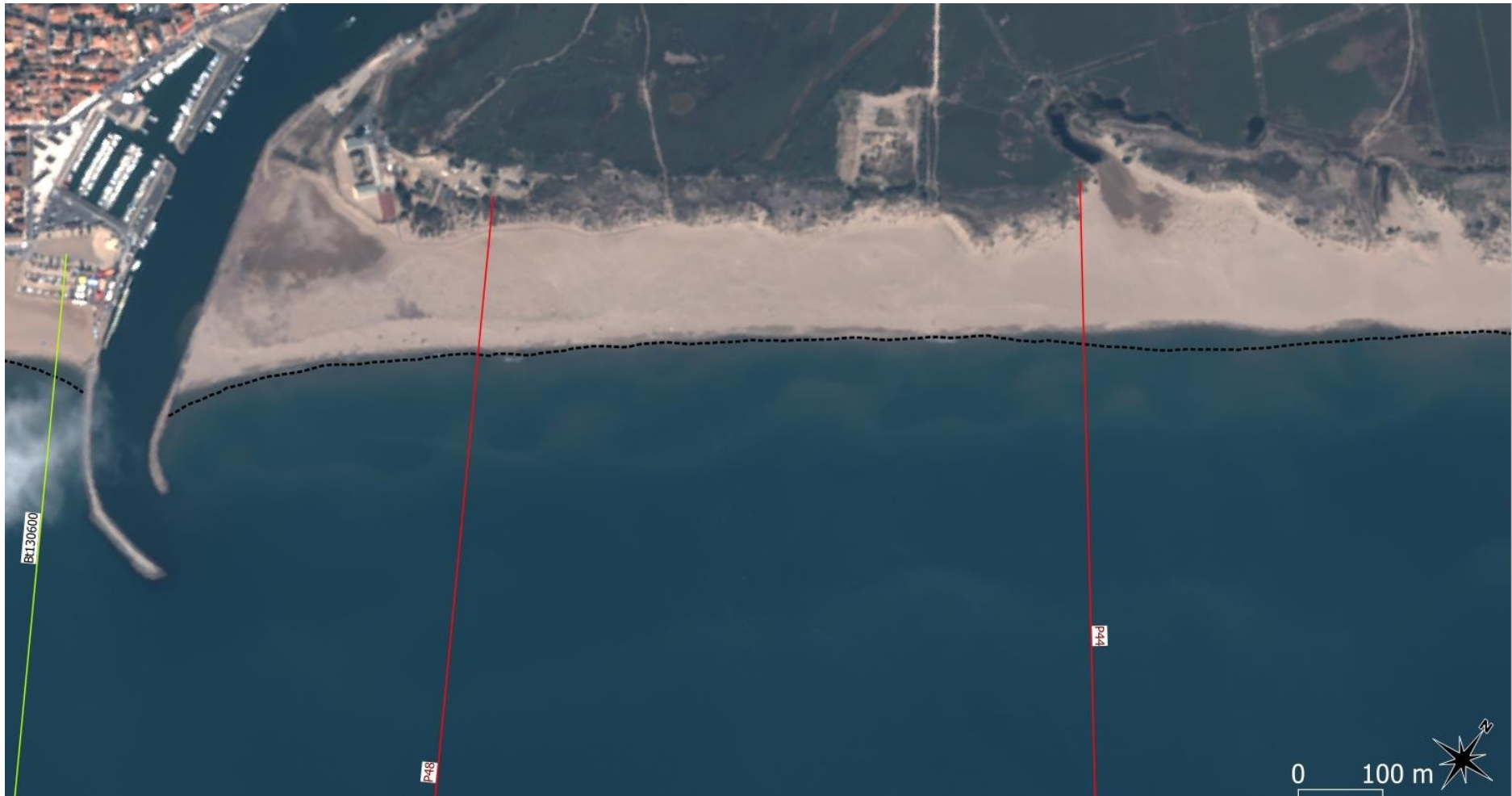
Figure 63 : ortho-photographie 2020 (Pléiades) du secteur 3 (Orpellières ouest) montrant la morphologie de la plage et des barres d'avant-côte (visibles par transparence de l'eau). La position du trait de côte en 2015 est rappelée par un trait pointillé noir.
