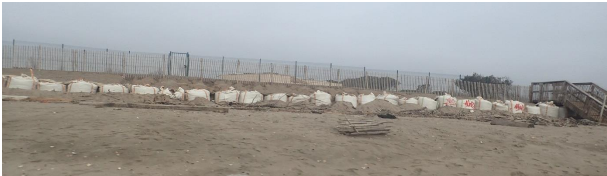
Figure 101 : photo des travaux de reconstitution de la partie détruite du cordon le 27 janvier 2020 avec un cordon étroit qui a été reconstruit à cœur grâce à des big-bags de sable
