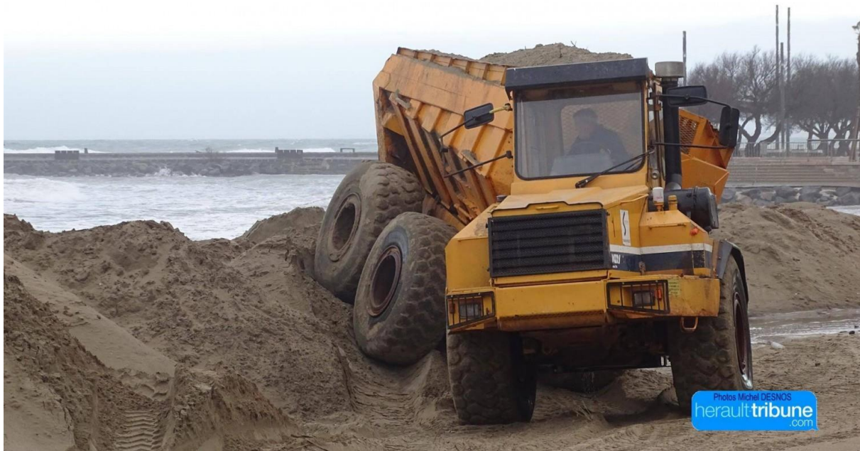
Figure 44 : travaux d'urgence de transfert de volumes de sable sur la plage d'Agde entre le secteur Saint-Vincent et la plage du Grau en érosion ( https://www.herault-tribune.com/articles/167712/littoral-apres-la-tempete-la-plage-du-grau-d-agde-est-reconstituee/ )
