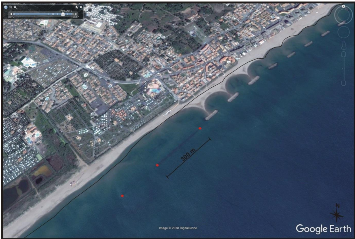
Figure 26 : Evolution de la situation du secteur de Valras ouest – Vendres avant et après les travaux, d'après une vue oblique Google Earth ©. Points rouges : limites des brise-lames immergés en enrochements et en géotextile, ouvrages placés sur une même ligne continue. Traits de côte de 2006 surligné sur les deux images
