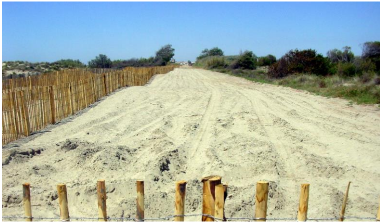
fin des travaux : du sable à la place de l'ancienne route
