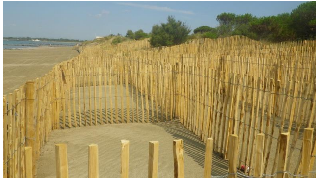
Secteur Tamarissière : Installation d'un ouvrage de restauration dunaire par la commune (Juin 2014)
