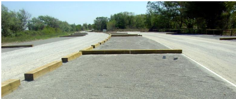
aire de stationnement le long de la 2x2 voies
