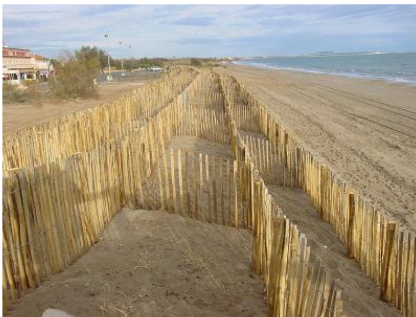
Photo 10 : Plage de la Redoute après les travaux le 29 Novembre 2010
