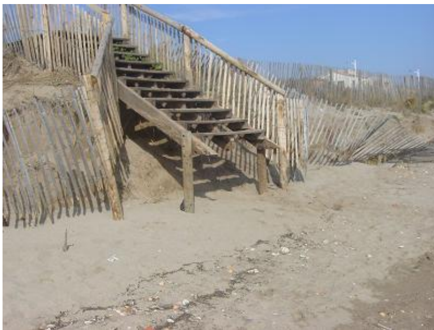
Photo 9 : Escaliers et ganivelles de la plage de la Redoute à Portiragnes le 4 Octobre 2010
