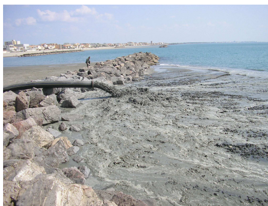
▲ Commune de Carnon, curage de l'avant port à l'aide d'une drague et redistribution des sédiments sur les plages.
