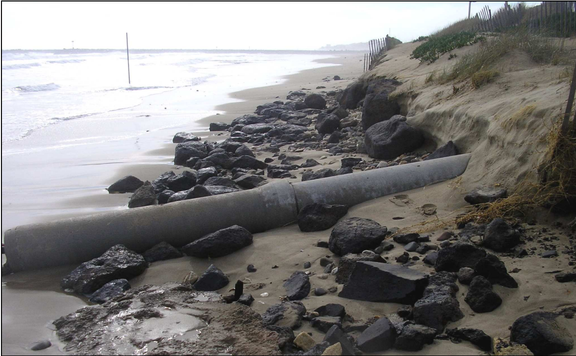
▲ Février 2010 : suite à un coup de mer, le départ du sable du haut de plage met à nu la nature hétéroclite du fond de plage dans ce secteur (talus d'enrochements, réseaux).
