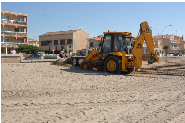
▲ Commune de Valras, redistribution du sable au bulldozer des petits fonds vers le haut de plage.
