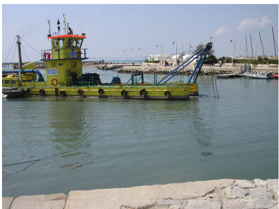
▲ Commune de Carnon, curage de l'avant port à l'aide d'une drague et redistribution des sédiments sur les plages.
