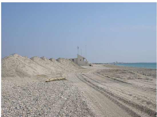
▲ Commune de Villeuneve-lès-Maguelone, redistribution du sable au bulldozer des petits fonds vers le haut de plage, au droit du poste de secours.
