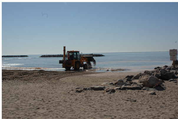
▲ Commune de Valras, redistribution du sable au bulldozer des petits fonds vers le haut de plage.
