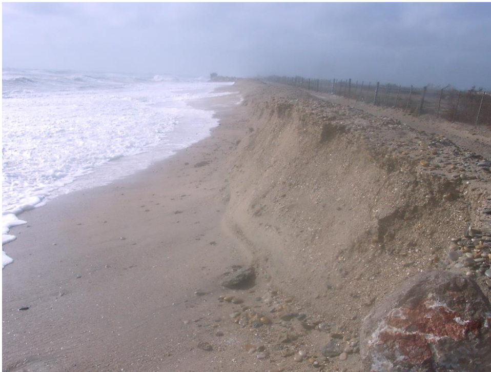
Figure 28. Vue sur le bourrelet dunaire artificiel qui protège la route de la plage au niveau du C.A.T. de Villeneuve lès Maguelonne le 19 octobre 2006. Quasiment la moitié du Cordon dunaire a été arrachée par les vagues lors de la tempête du 19 octobre 2006.
