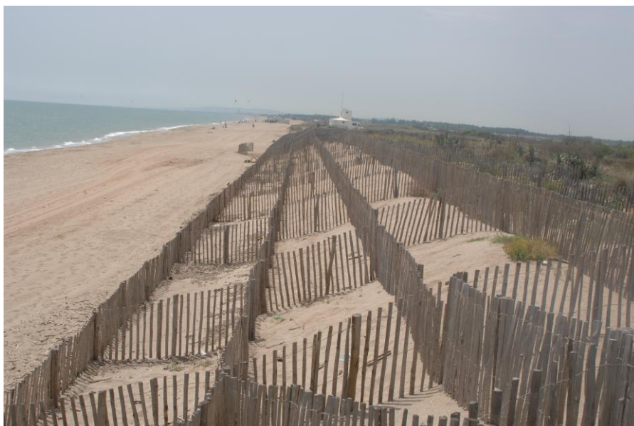
Figure 39. Vue de l'ouvrage au niveau du profil P28 à Portiragnes. Mai 2007.
