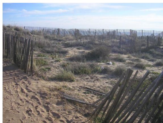
Dégradation des ouvrages en ganivelles, à Agde (à gauche), à Portiragnes (à droite)
