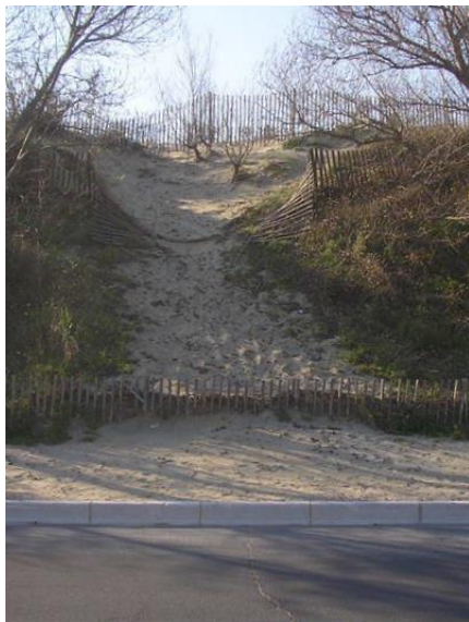
Dégradation des ouvrages en ganivelles, à Agde (à gauche), à Portiragnes (à droite)
