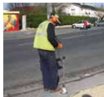
Réalisation d'une écoute au sol (source : Irstea)
