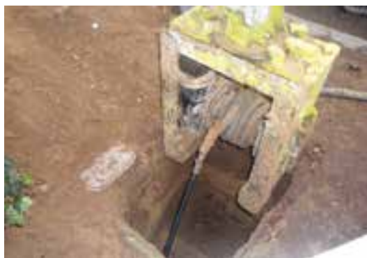
Remplacement d'un branchement plomb par traction (source : SEDIF)
