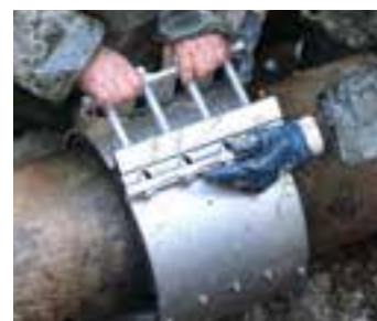
Installation d'un manchon de réparation (source : Norham)
