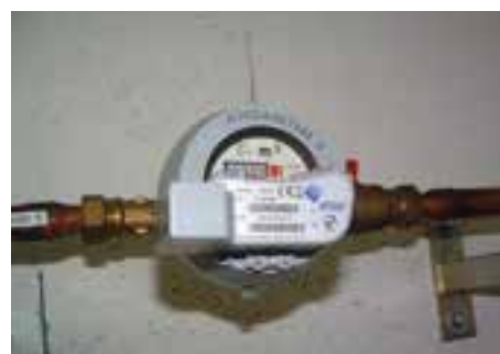
Compteur d'eau d'un abonné (source : OIEau)
