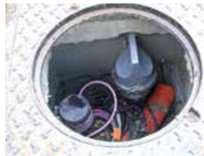
Dispositif de télégestion (source : Sofrel)
