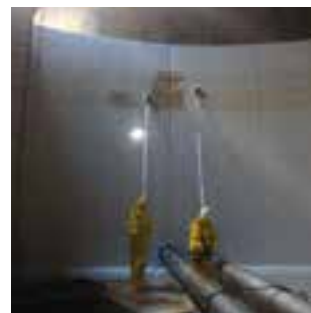
Lavage d'un réservoir (source : Herli)
