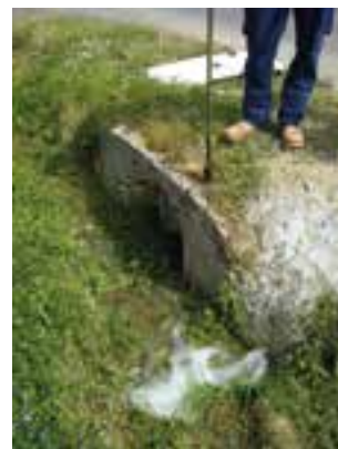
Réalisation d'une purge (source : Irstea)
