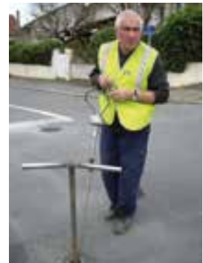
Réalisation d'une écoute directe mécanique (source : Irstea)
