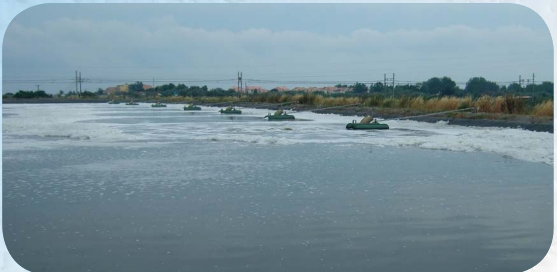
STEP de Marseillan : épuration des eaux usées par lagunage aéré. Photo : G. Soteris
