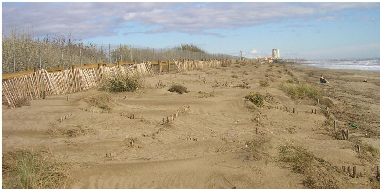
Secteur est de la plage de Vendre, au droit du camping ; l'ouvrage en ganivelles est saturé en sable, mais la végétation est loin d'avoir colonisé la surface dunaire et reste clairsemée ; la lisse en pin et la ligne de ganivelles visibles à gauche délimitent un cheminement longitudinal type "sentier du littoral".
